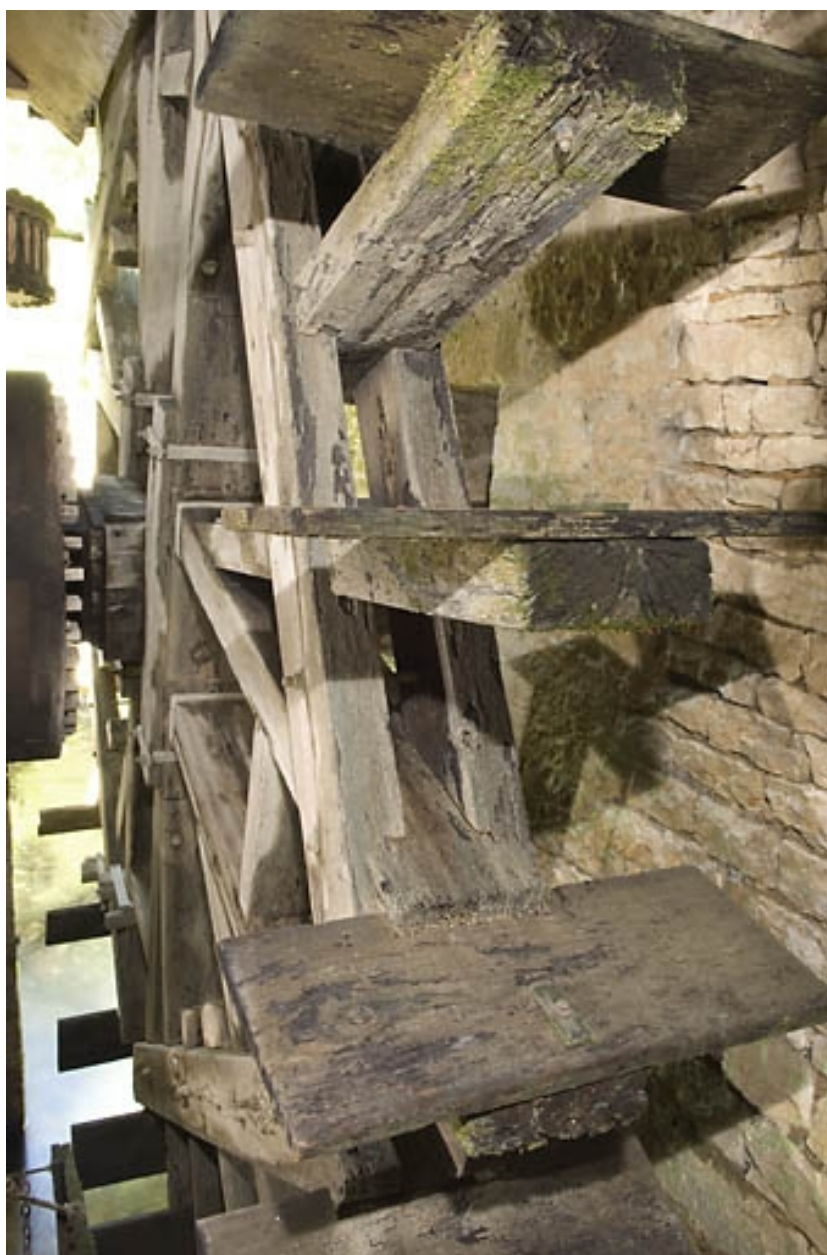
Détail de la roue hydraulique.
