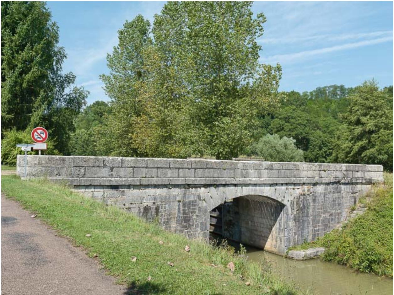
Vue d'ensemble du pont.
