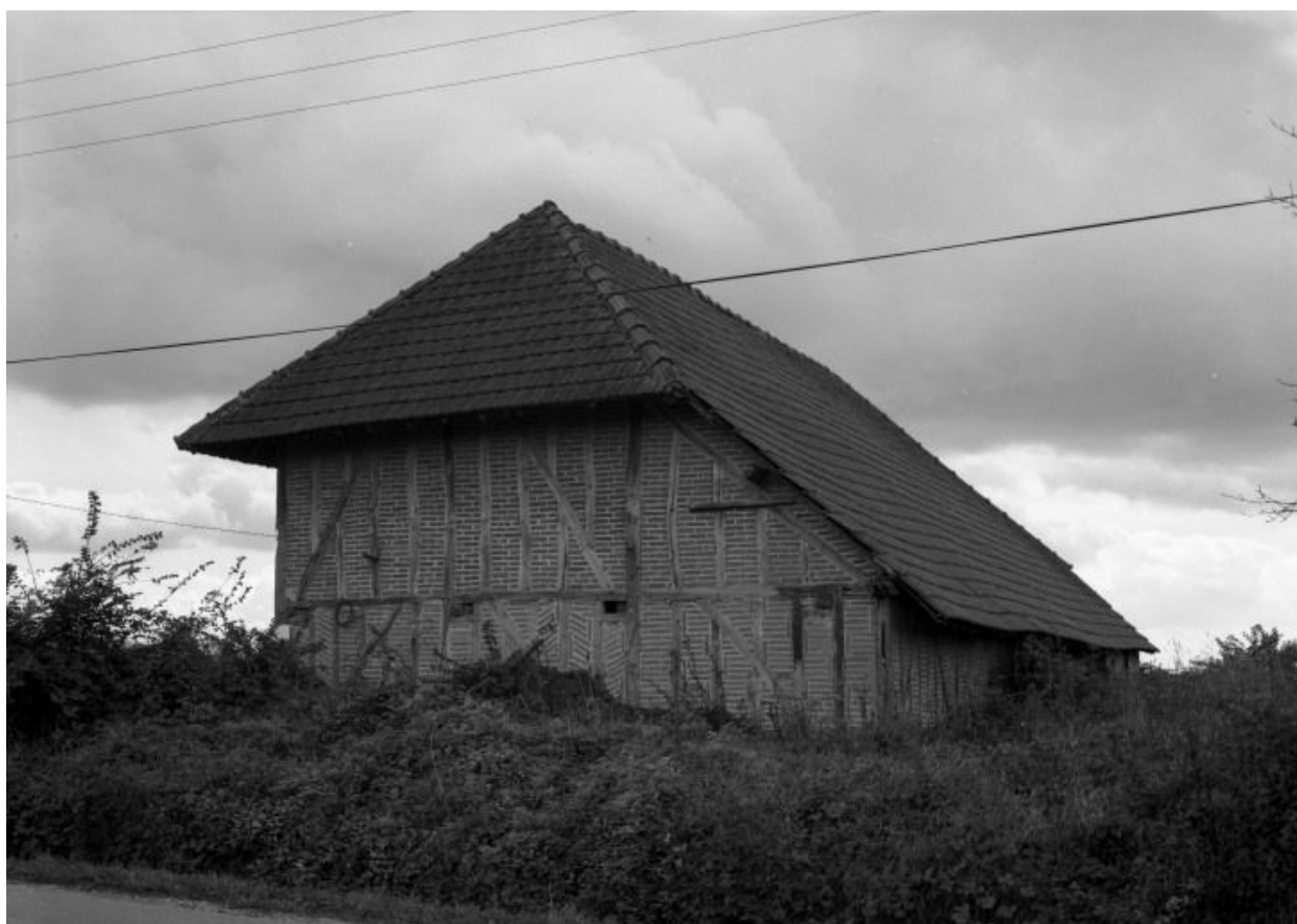
Elévations latérale et postérieure.
