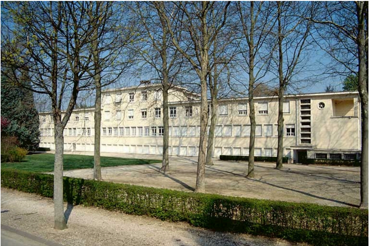
Façade postérieure, vue de trois-quarts depuis la droite.
