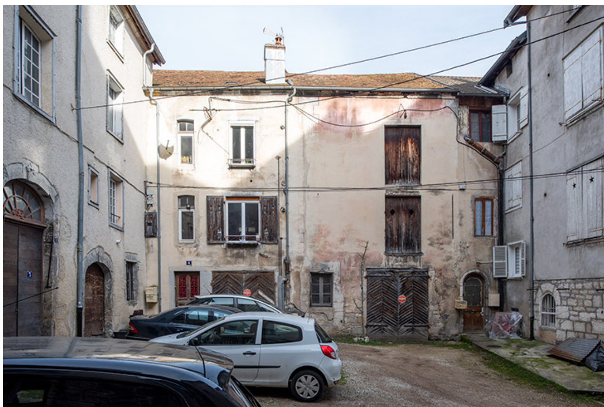
Vue d'ensemble depuis le sud.
