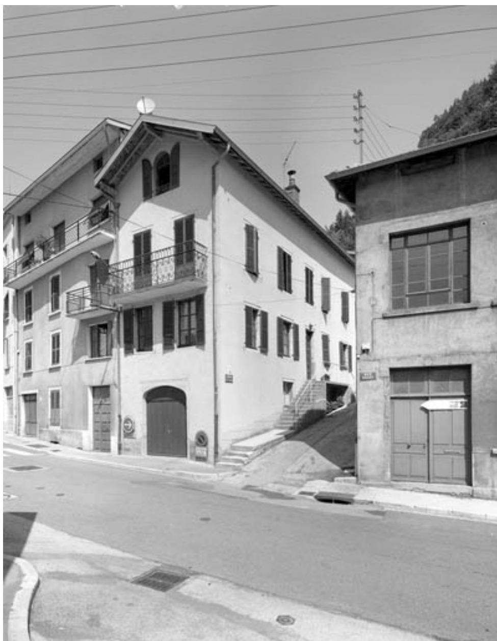
Vue d'ensemble depuis la rue Rosset.
