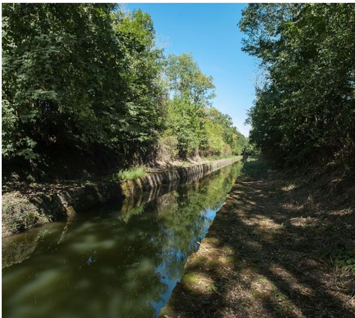
Vue d'ensemble de la tranchée.
