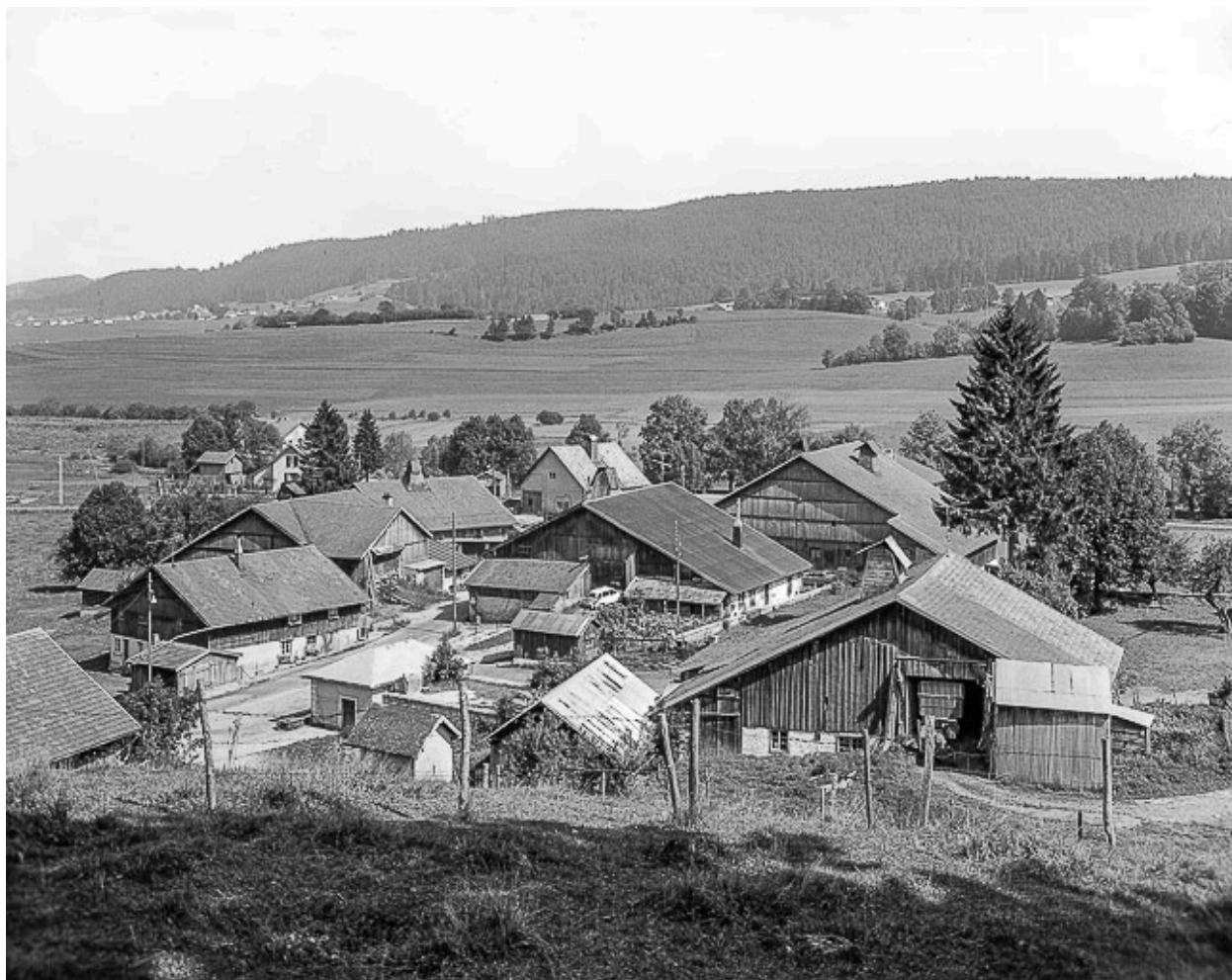
Hameau des Cordiers : façades postérieures des fermes.
