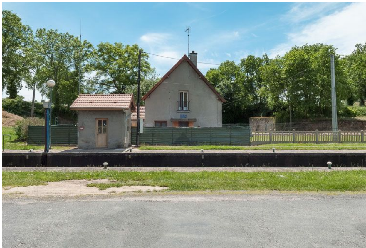
Vue de face de la maison éclusière.
