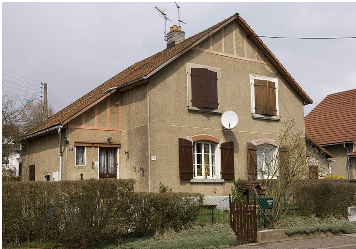
Maison à deux logements (côté impair).
