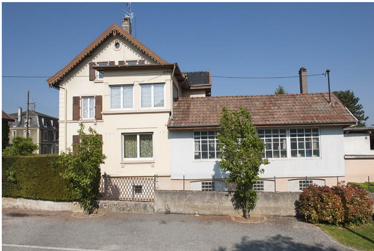
Pignon et façade sud de l'atelier.
