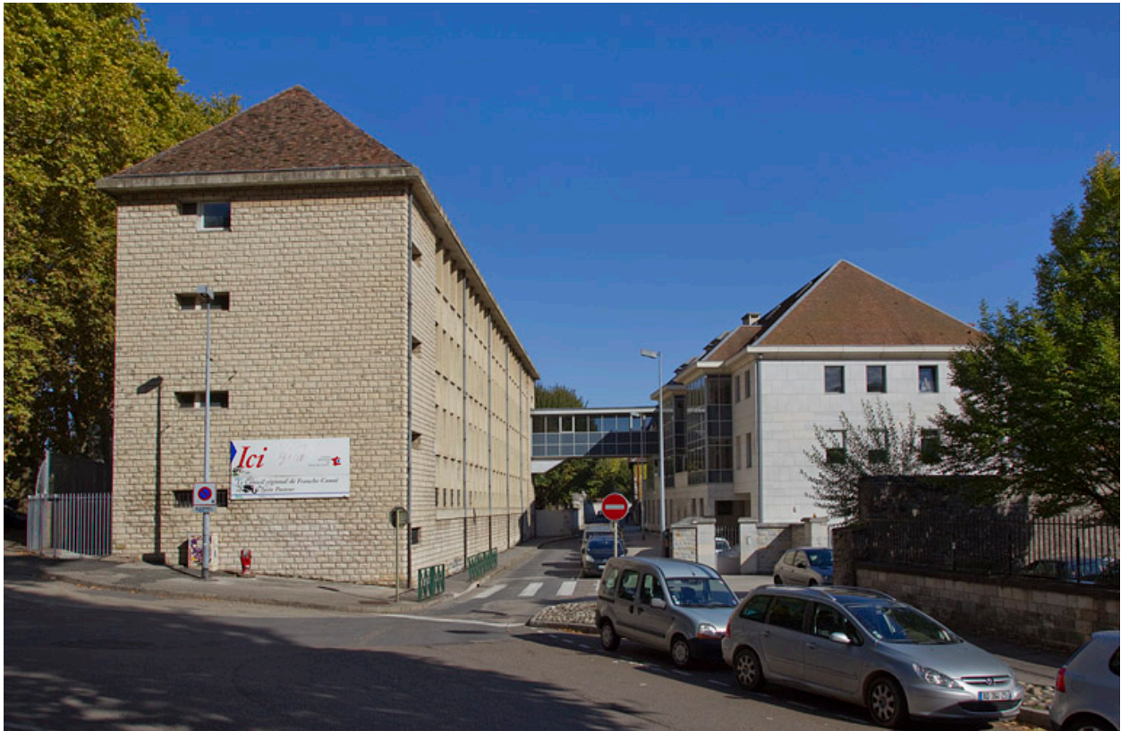
Vue générale des bâtiments Chamars et Charvet reliés par la passerelle.
