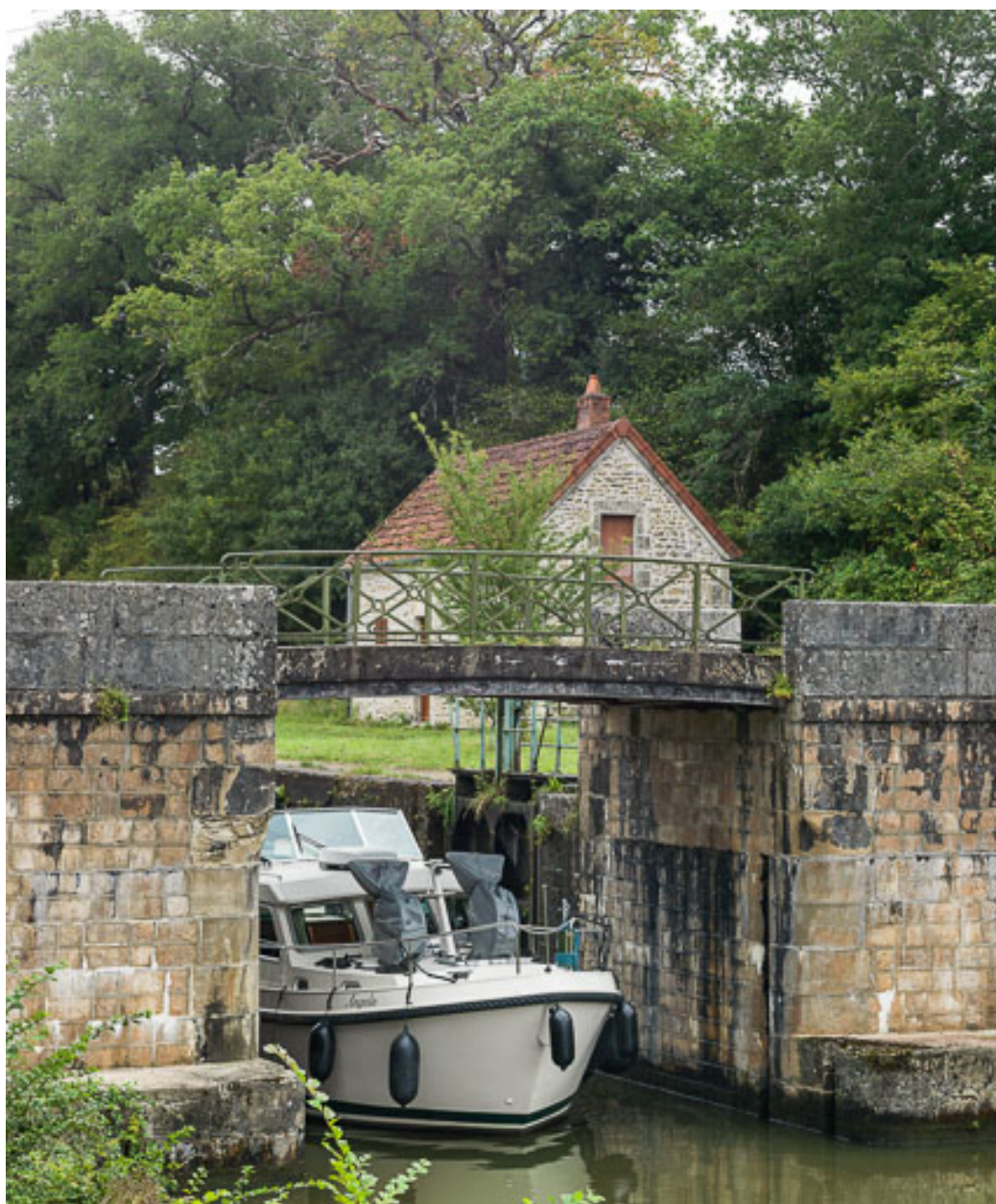
Vue du pont.
