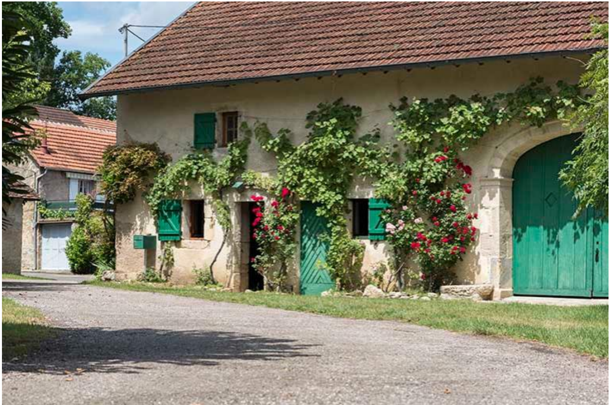
Vue extérieure de l'écurie et du grangage
