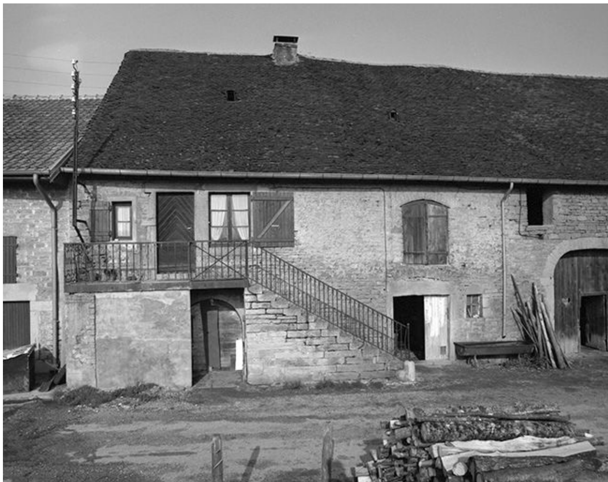
Façade antérieure : l'habitation.
