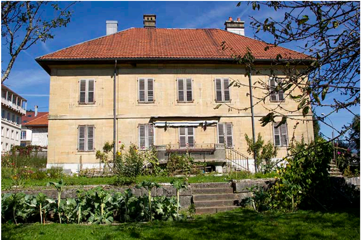
Corps sud : façade latérale droite.
