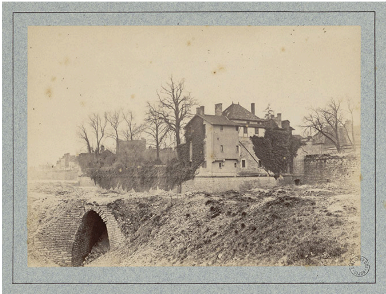
Bastion de Saulx (rue Diderot) et petit pont sur le Suzon. S.d. [vers 1880].
