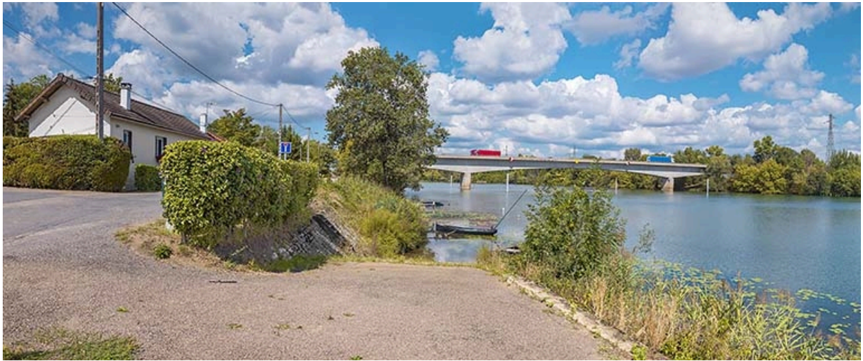
Rampe et perré du port.
