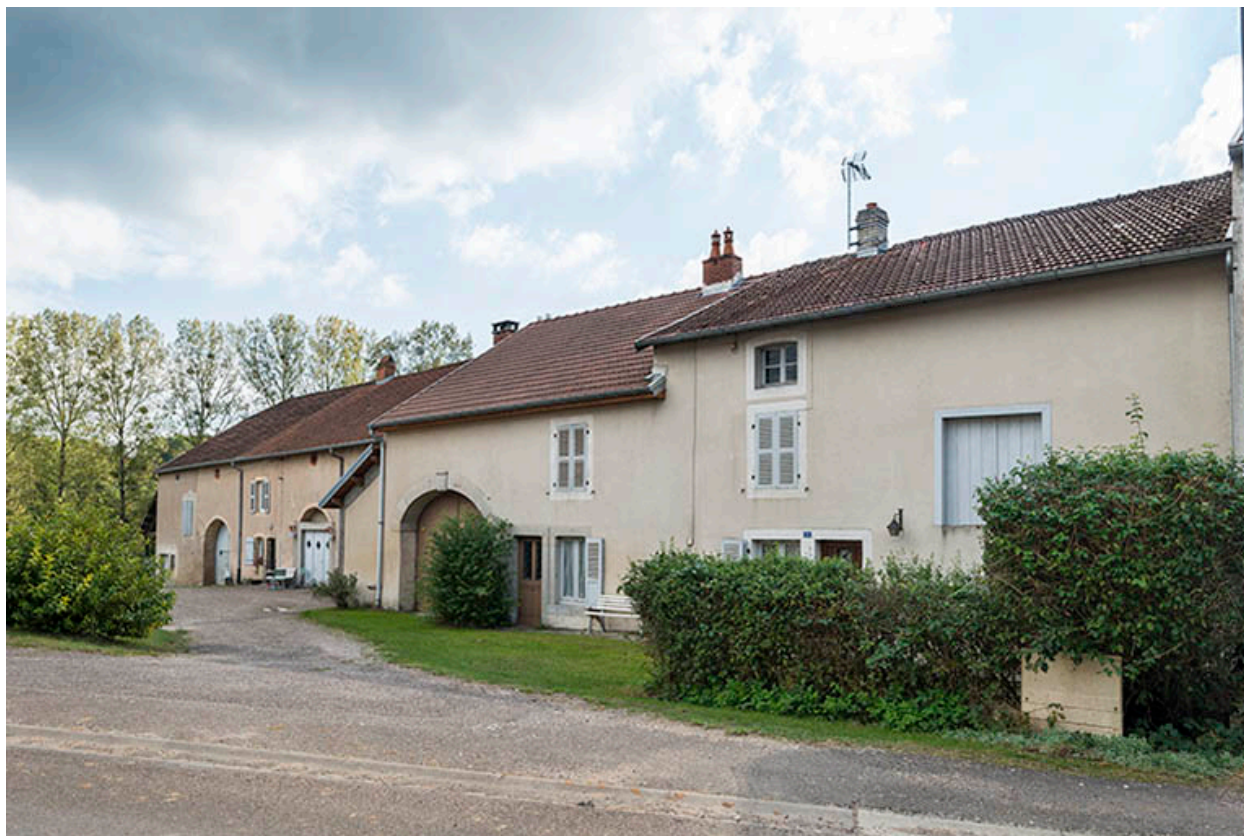
Vue depuis la Grande rue.
