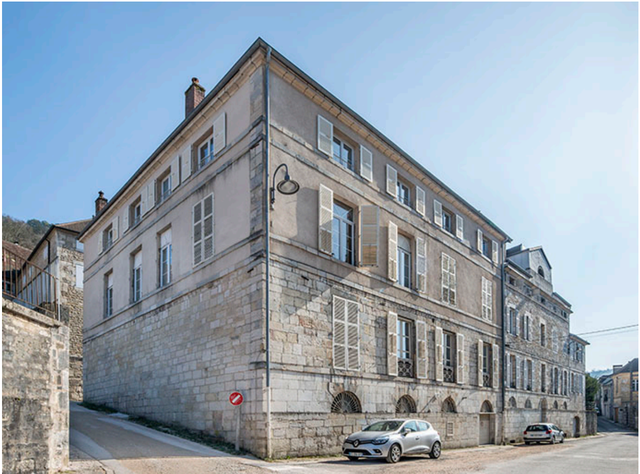
Vue de trois quarts, depuis le nord-ouest.
