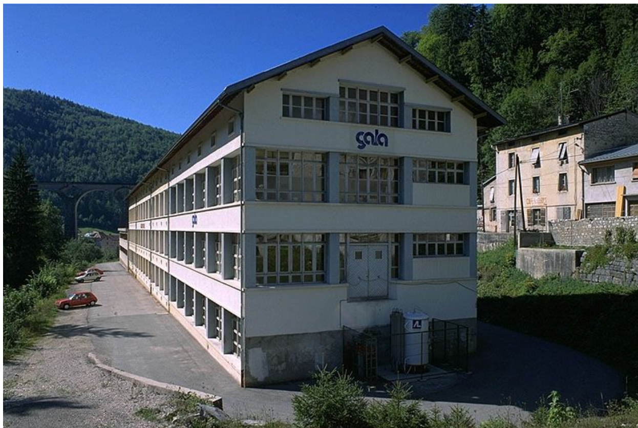
Façades postérieure et latérale gauche.
