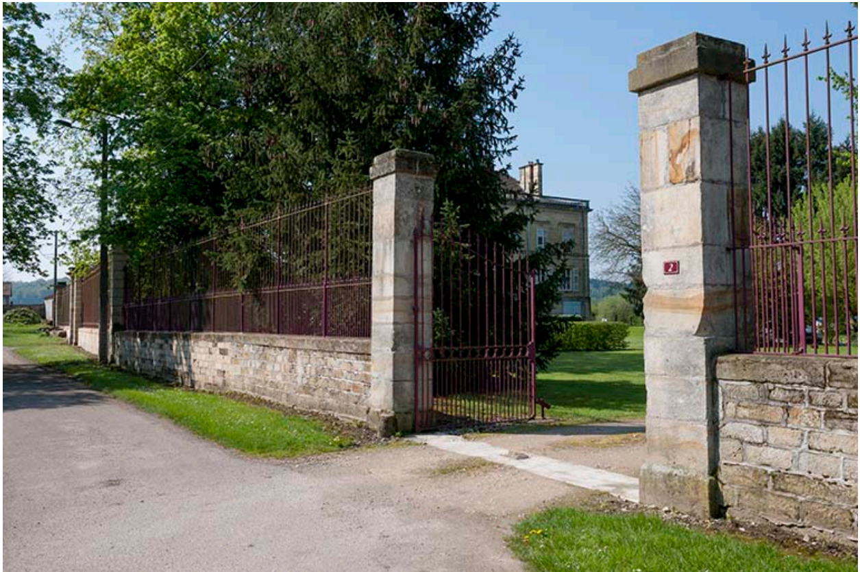
Portail d'accès aux parties agricoles.
