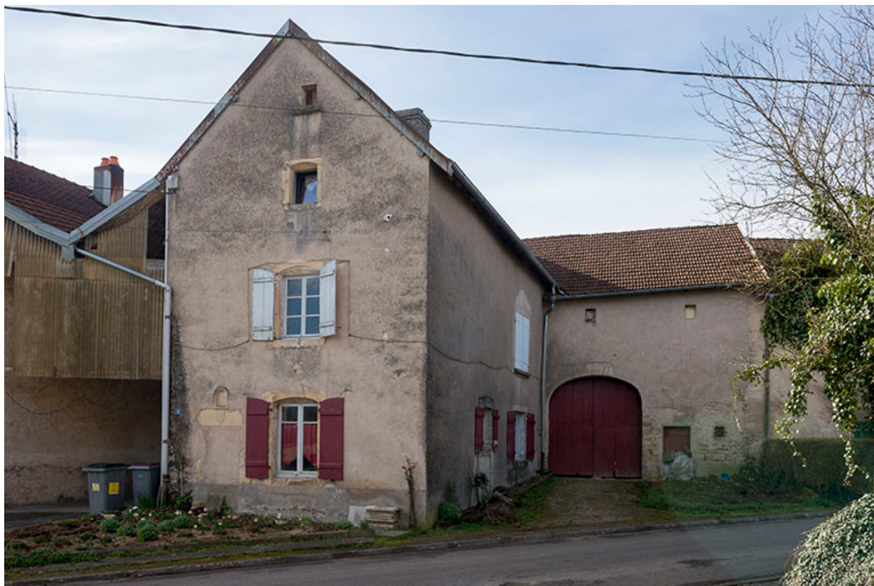
Ferme en équerre, rue du Bac.
