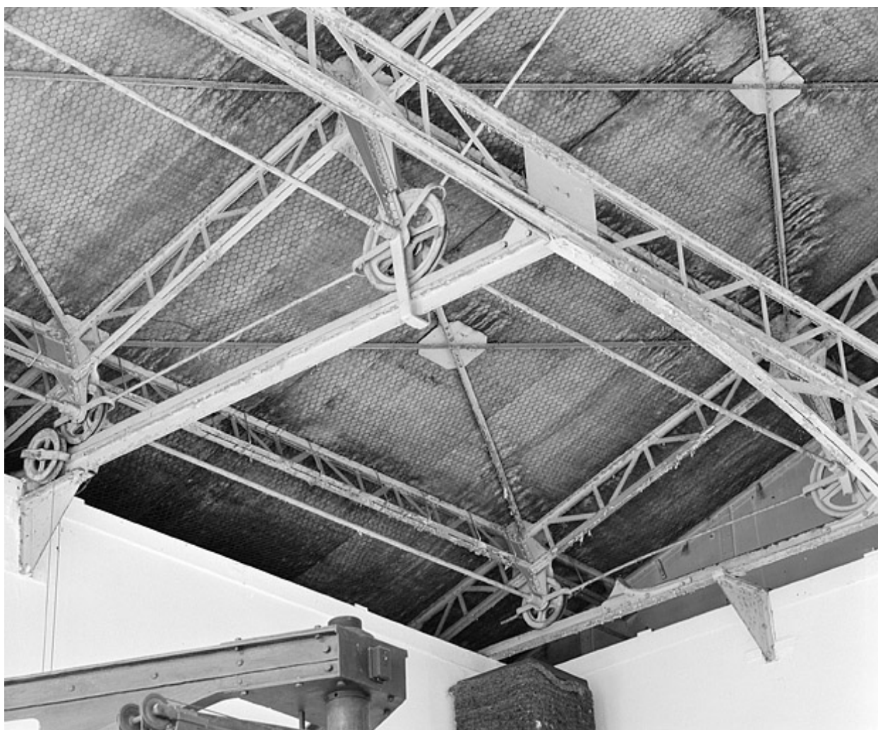
Système d'ouverture de la toiture : poulie, roues métalliques et rails.
