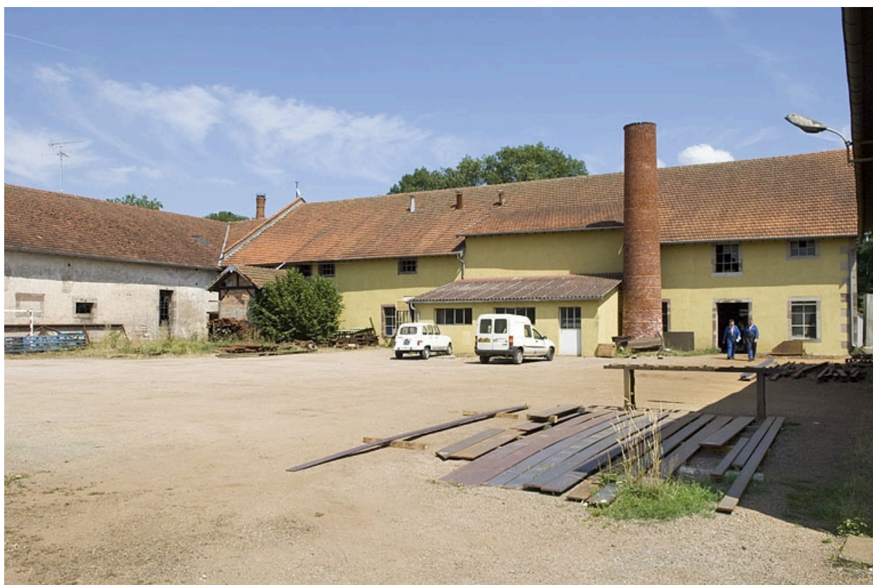
Bâtiments industriels depuis la cour.
