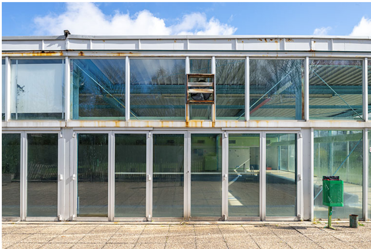
Détail de la façade sud-ouest.
