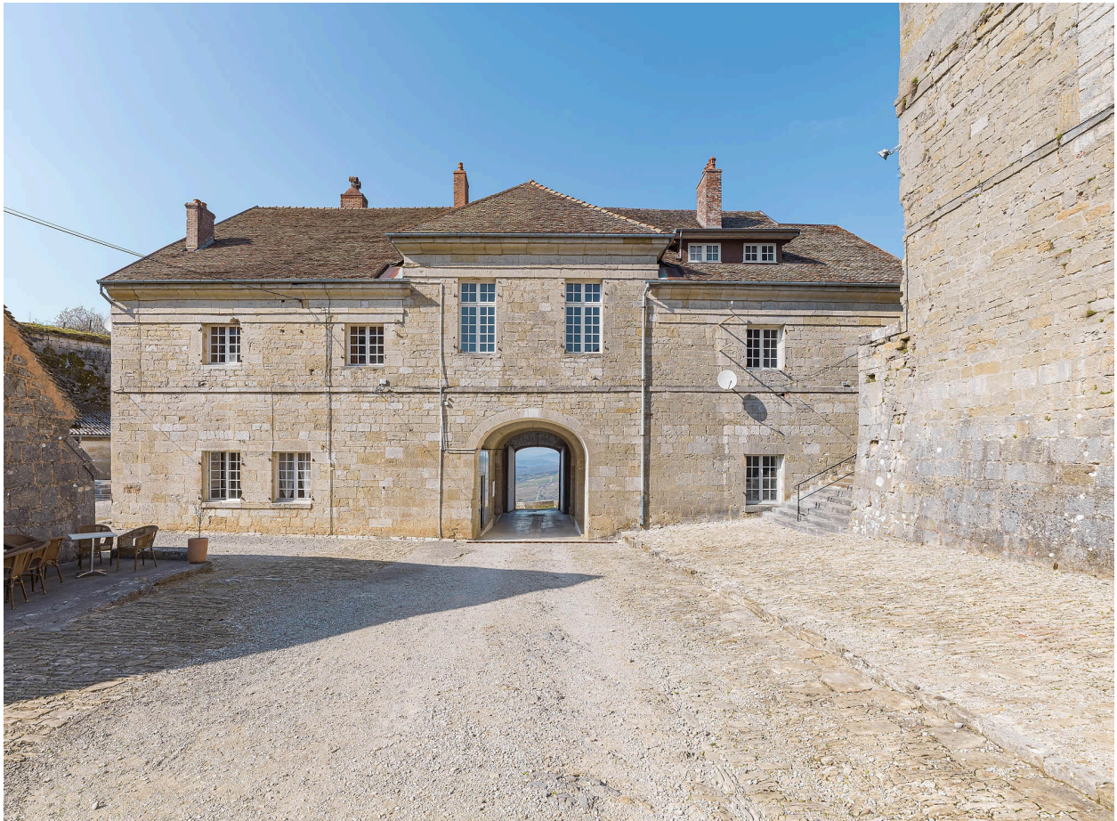
Façade postérieure du bâtiment.
