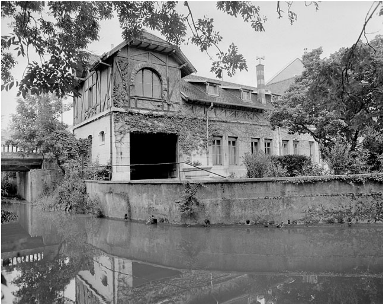
Partie méridionale des écuries et des remises.
