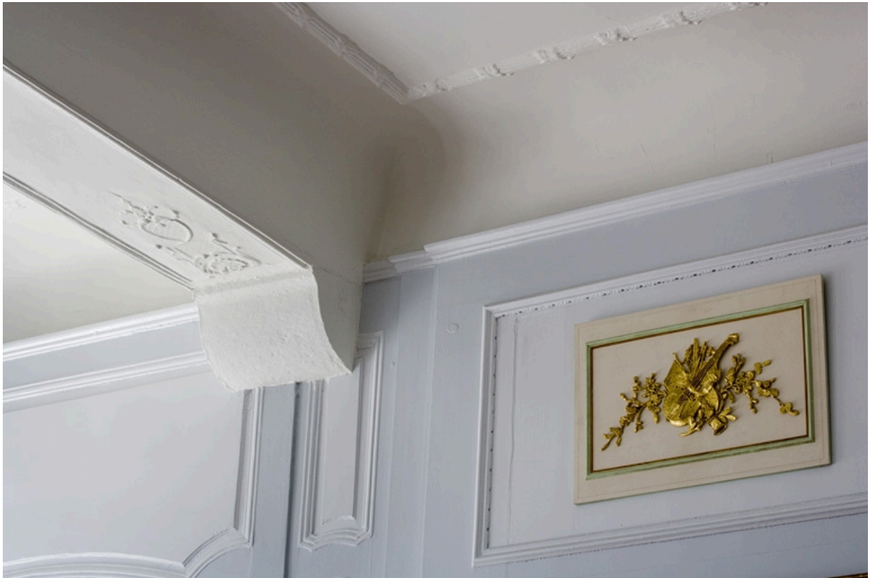
Intérieur, premier étage : détail d'une poutre du plafond, chambre à gauche du salon.
