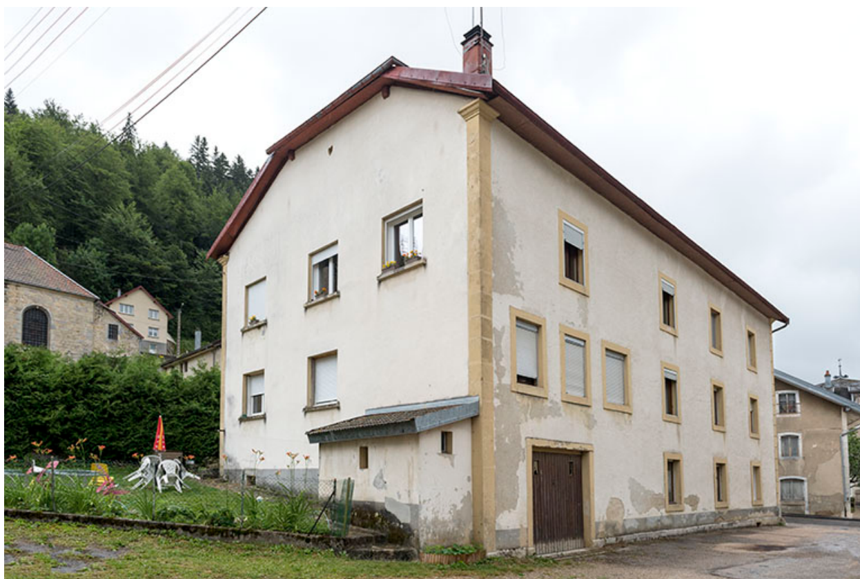
Façades postérieure et latérale gauche.
