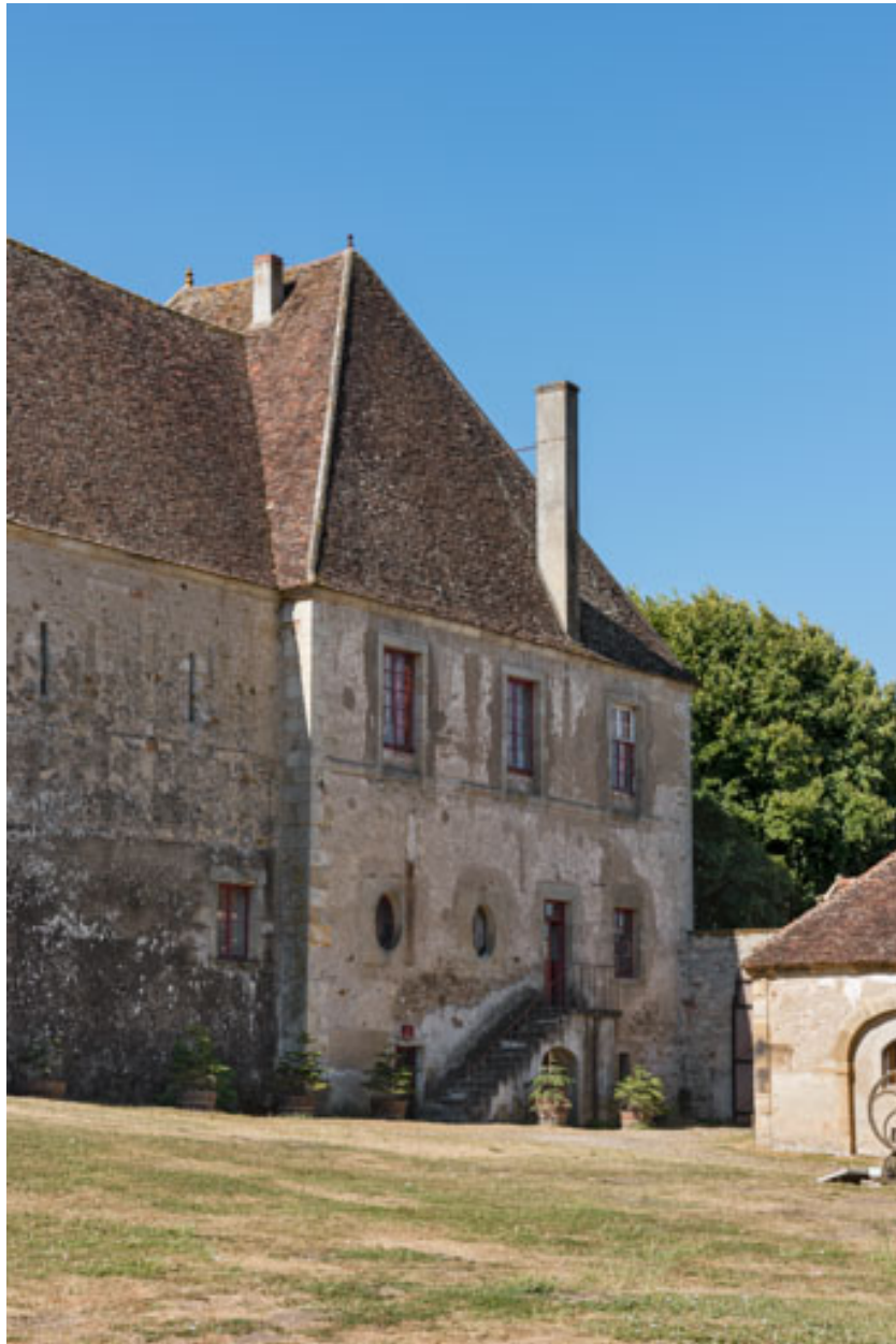
Façade postérieure : pavillon occidental.
