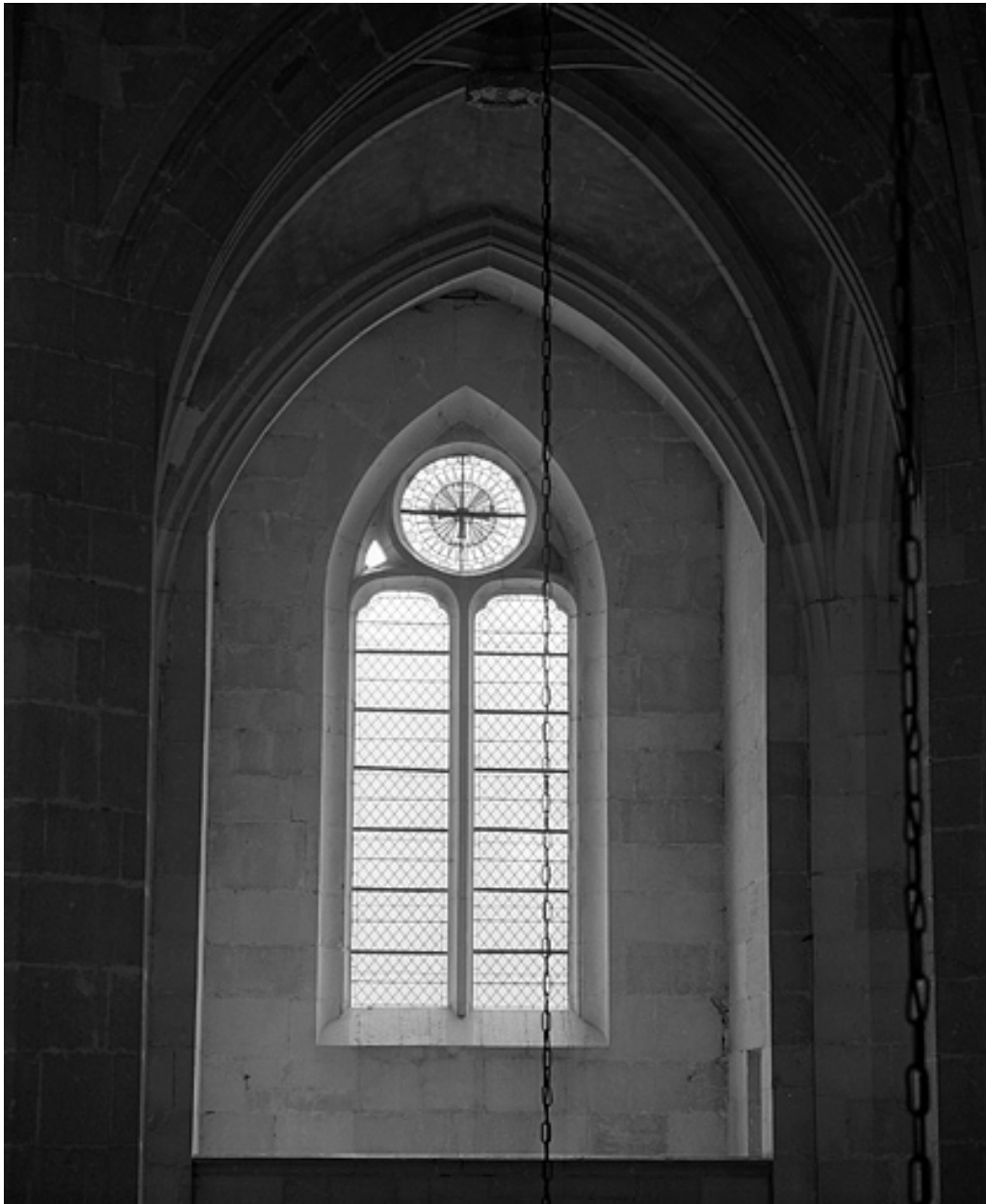
Baie de la troisième travée du collatéral sud.
