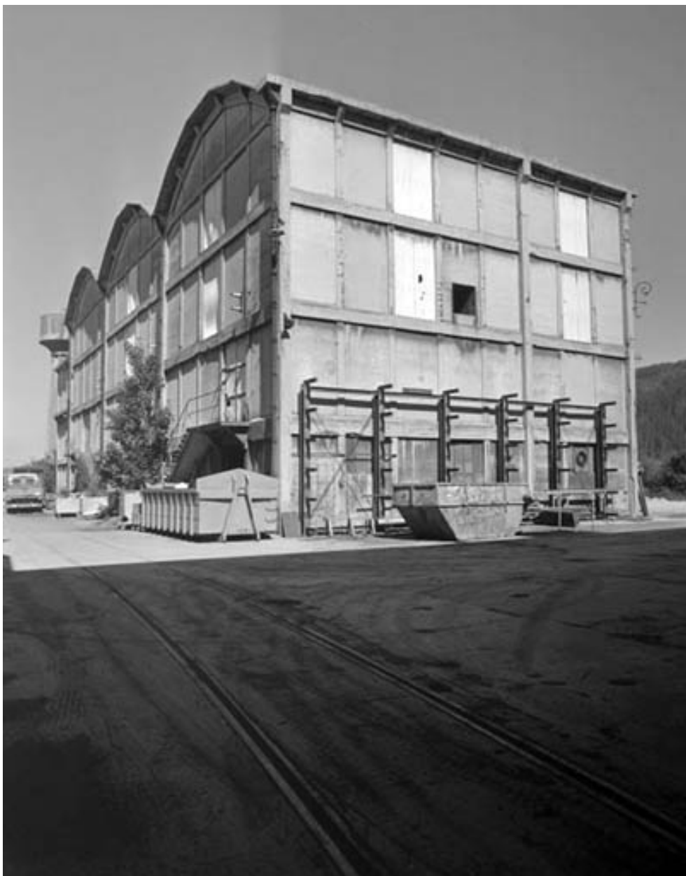
La centrale thermique vue de trois quarts.
