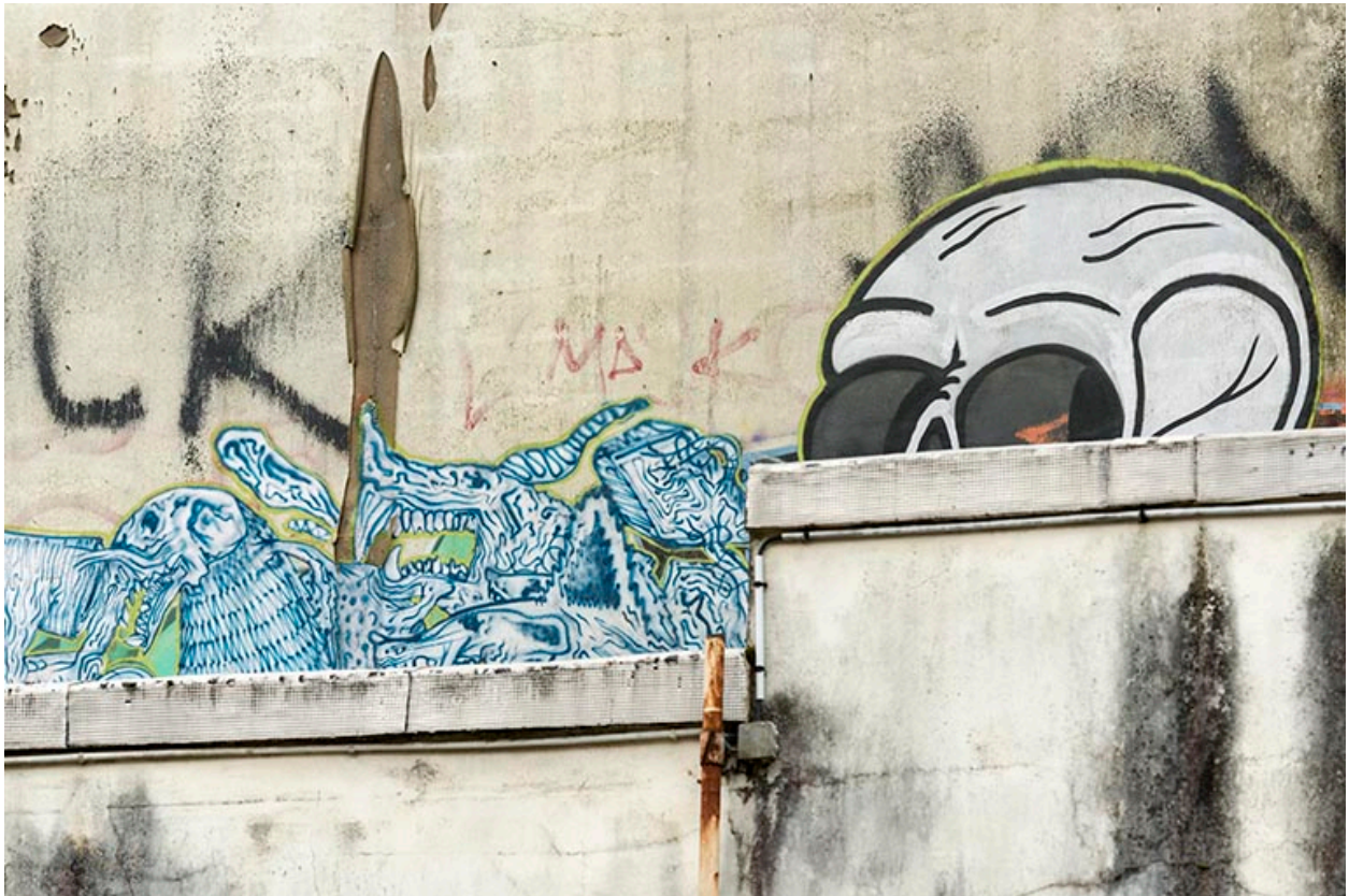
Etat en 2016. Usine A : tags, à l'extrémité occidentale de l'étirage tergal.
