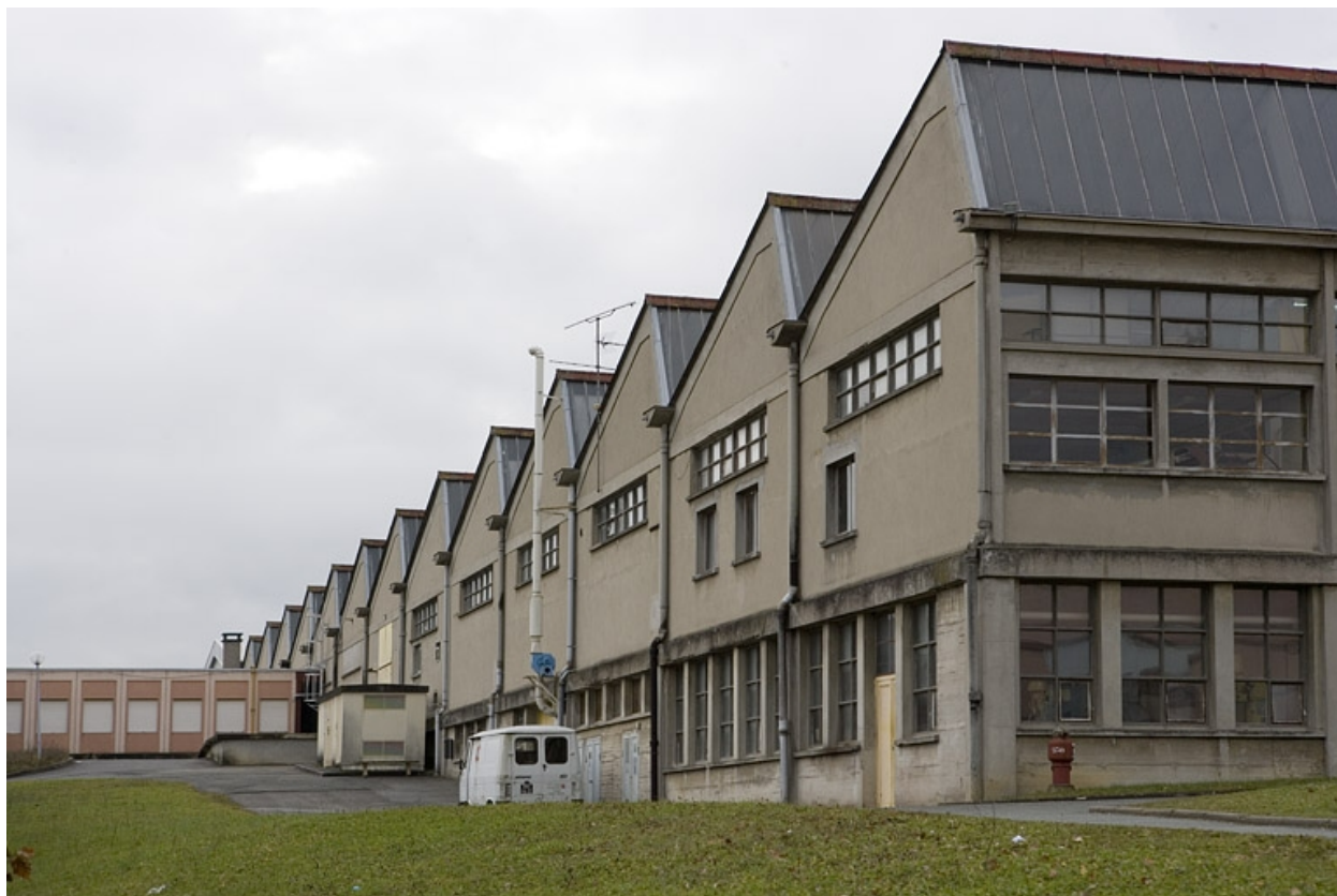
Vue de trois quarts droit bâtiment B.
