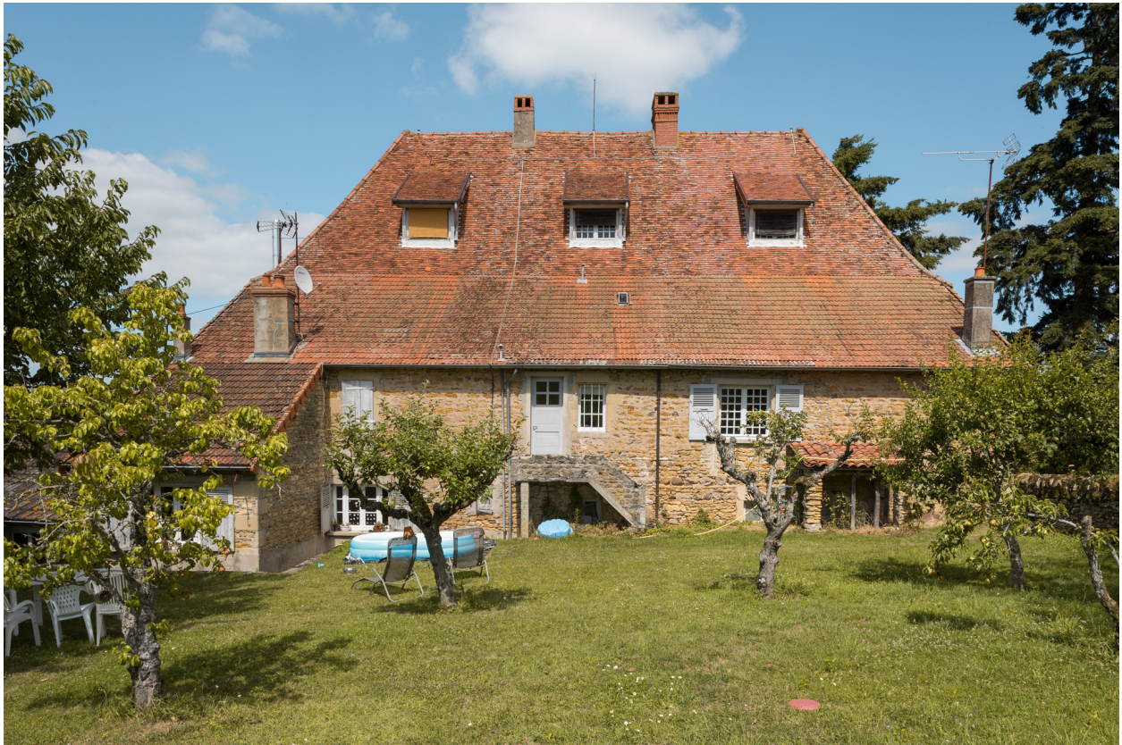
Façade postérieure du logement.
