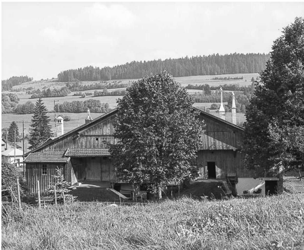
Façade postérieure en 1976.
