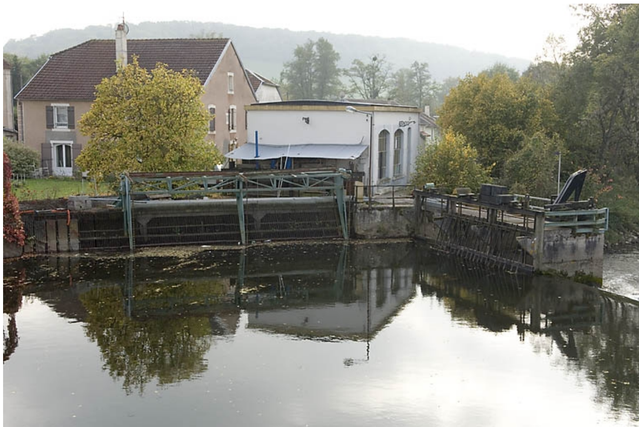
Vue d'ensemble depuis le pont.
