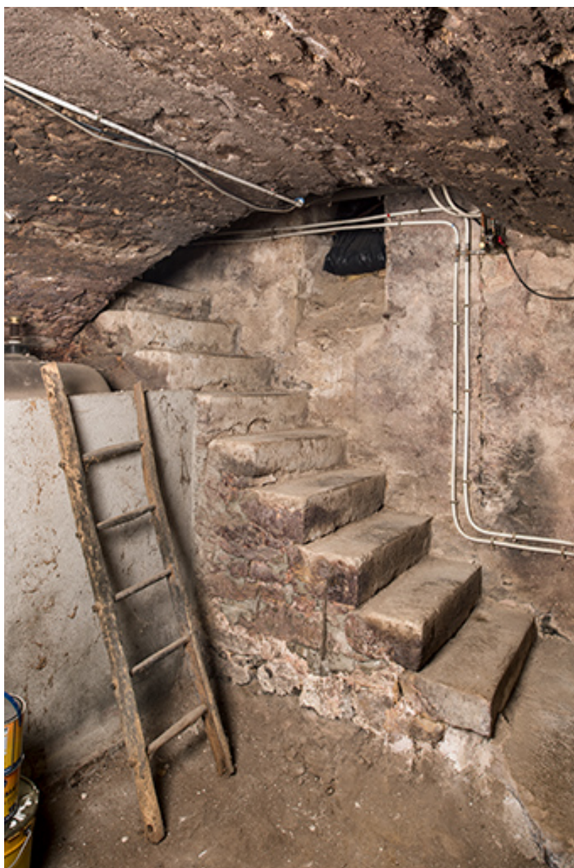
Le premier cellier et l'escalier d'accès intérieur à la maison.
