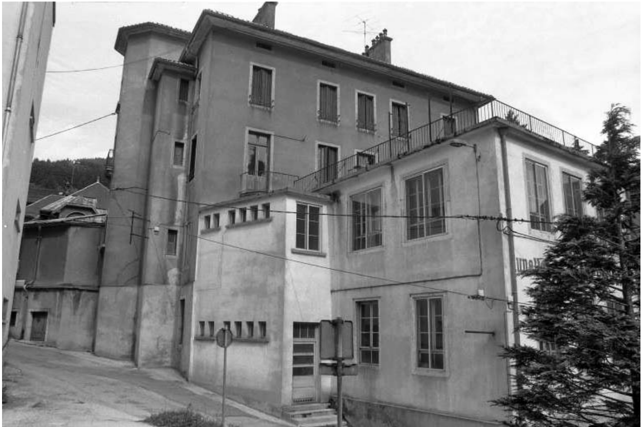
Façade postérieure et atelier sur la rue Fenandre.
