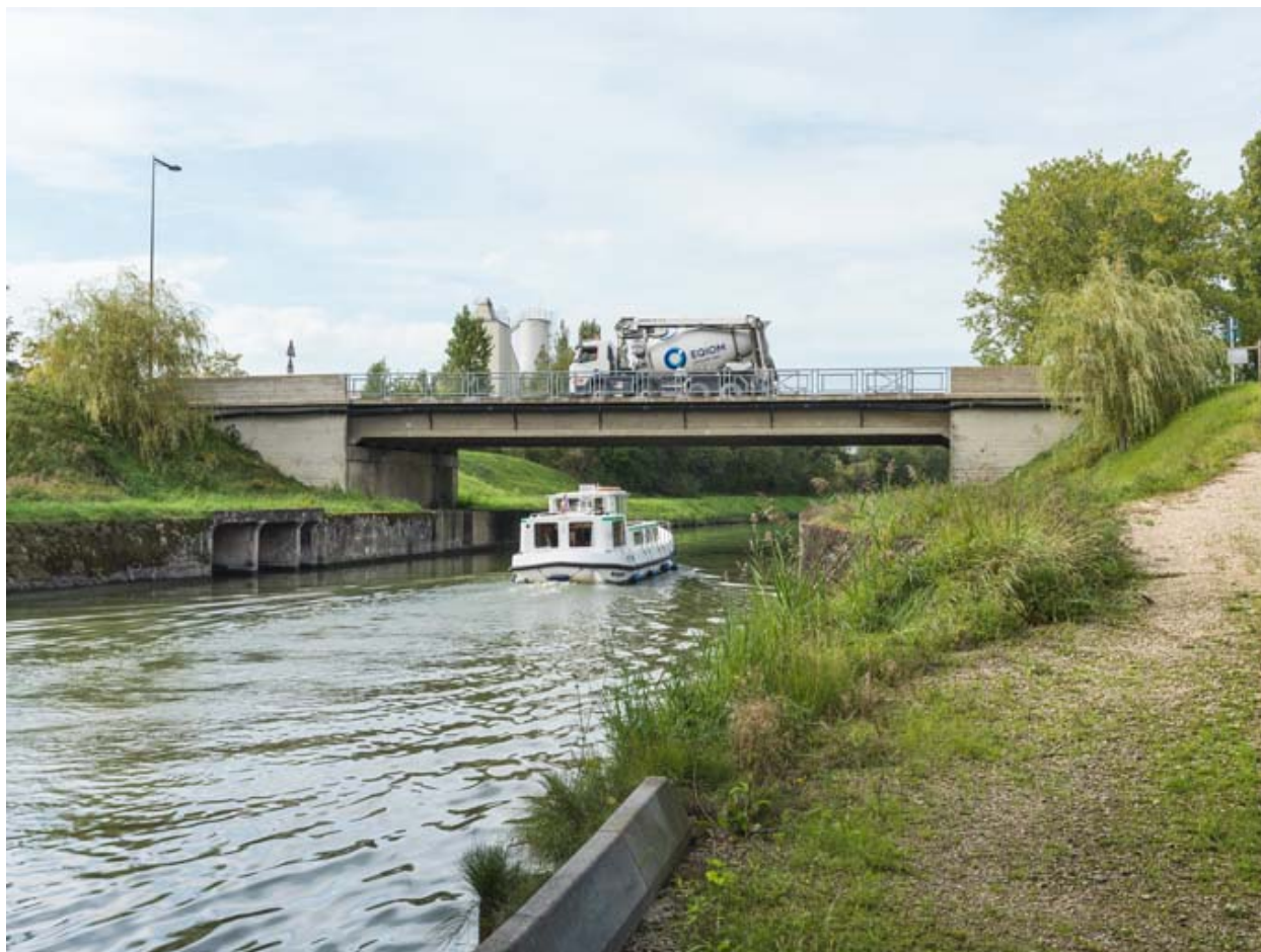
Vue d'ensemble du pont.
