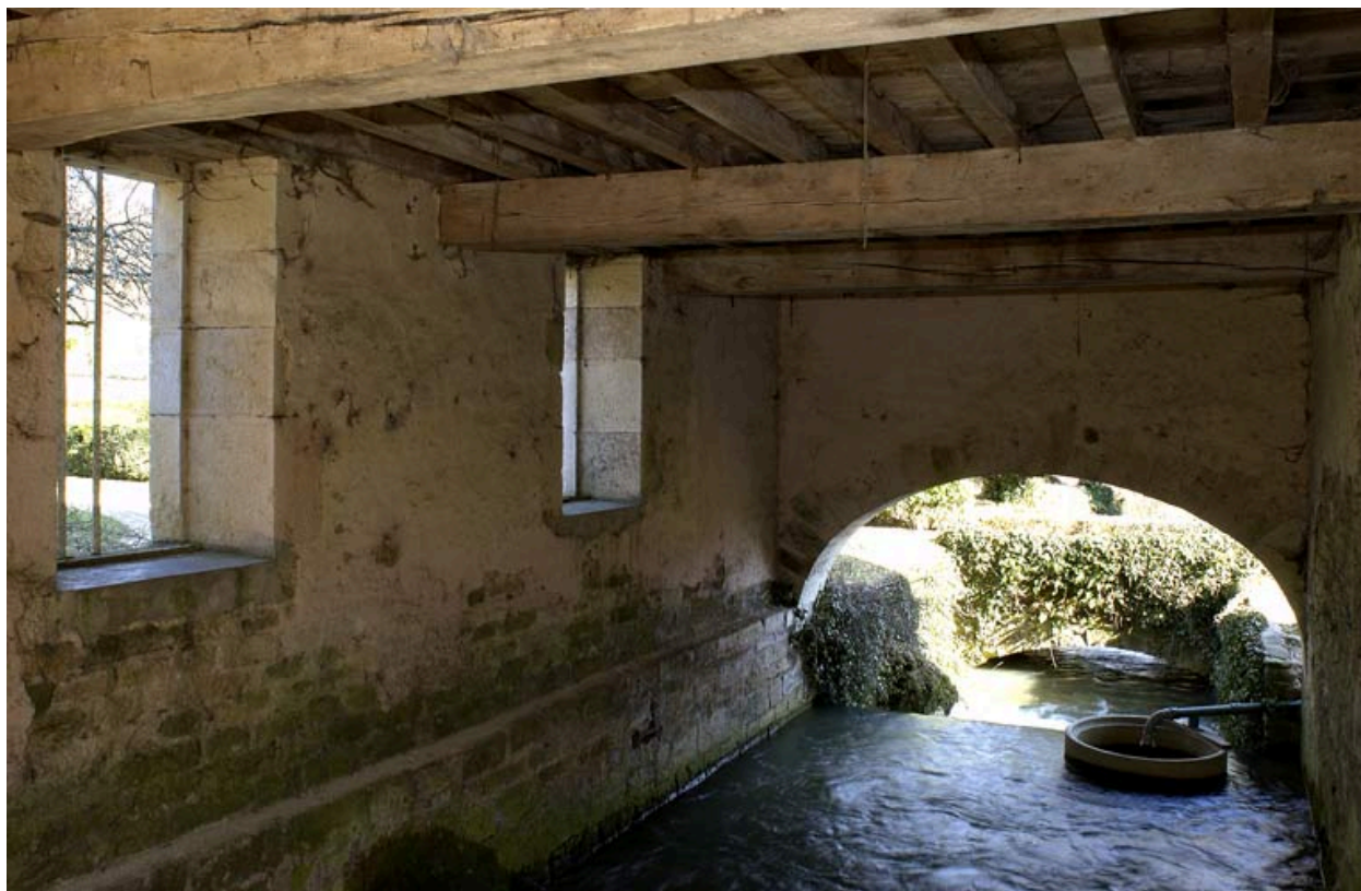
Ancien moulin à eau : bief.
