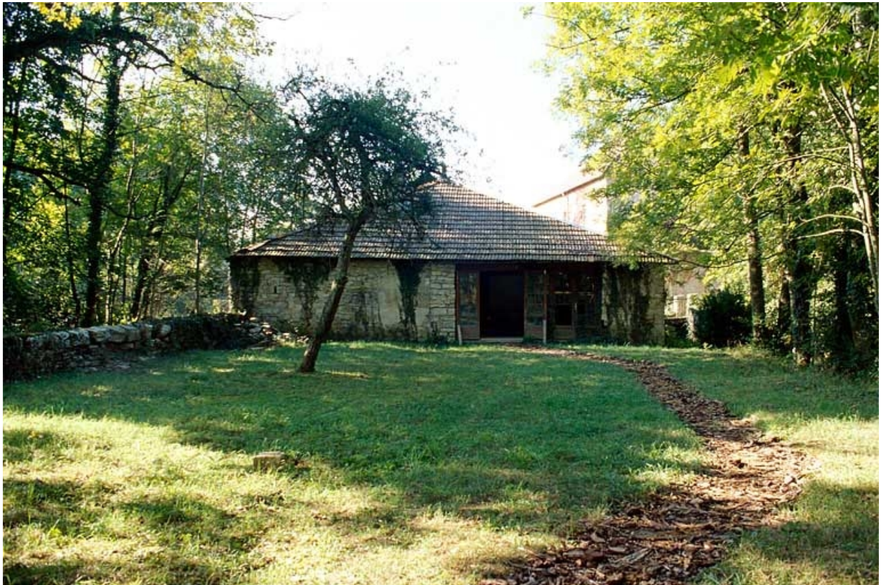
Extrémité ouest de l'atelier de la forge.
