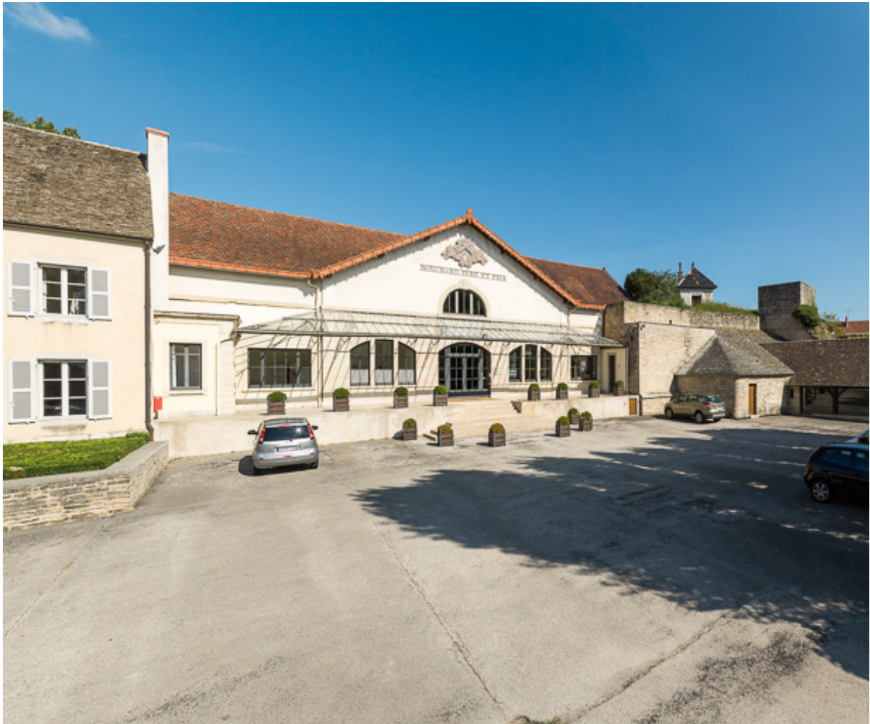
Façade antérieure des anciens chais, aujourd'hui bureaux, installés sur l'ancienne esplanade du château.
