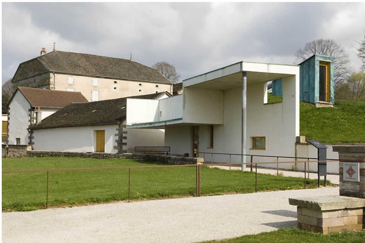
Vue d'ensemble de l'Ecomusée depuis l'entrée.
