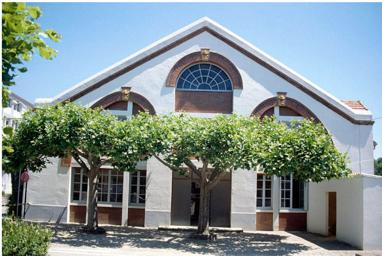
Façade antérieure des bureaux, vue de face.
