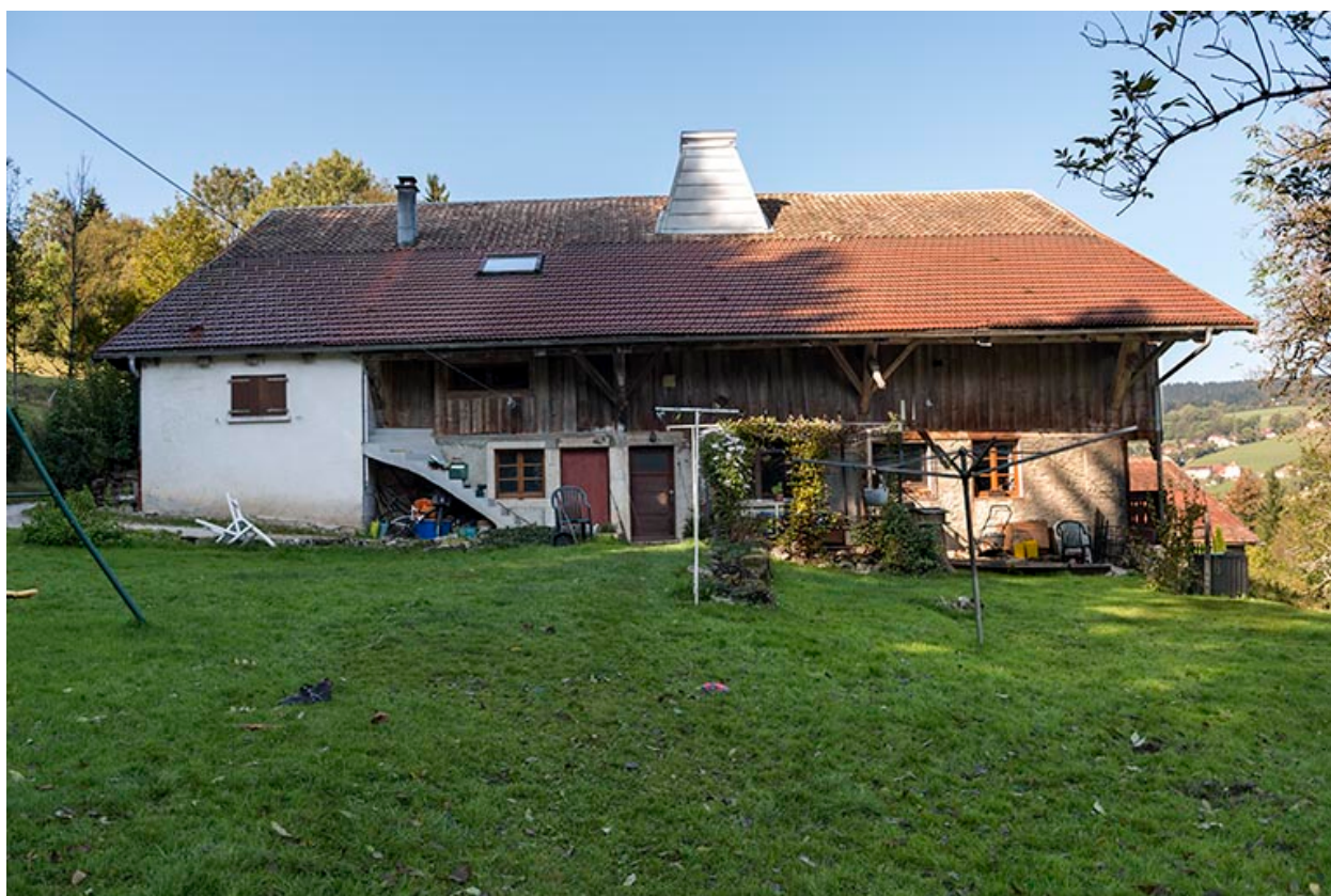
Façade latérale droite.
