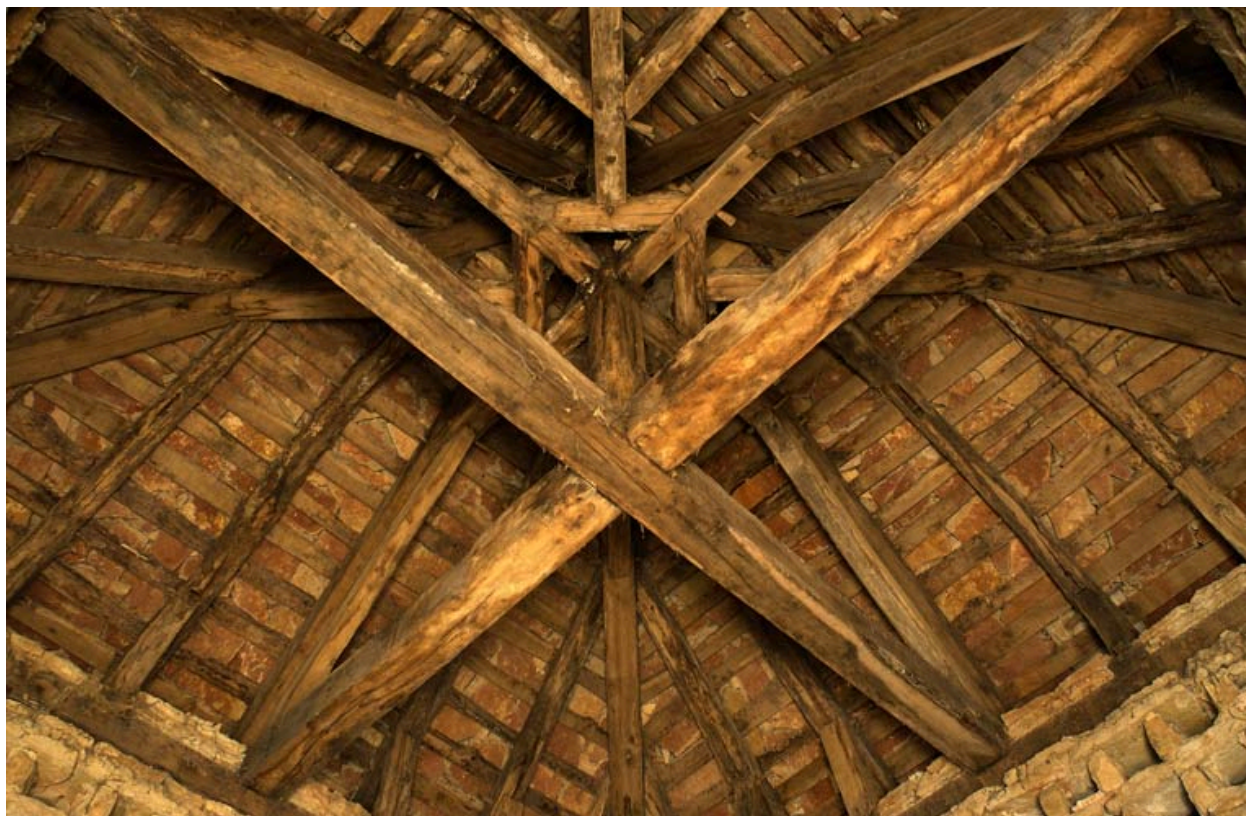
Colombier dit pigeonnier à écrevisses : charpente.
