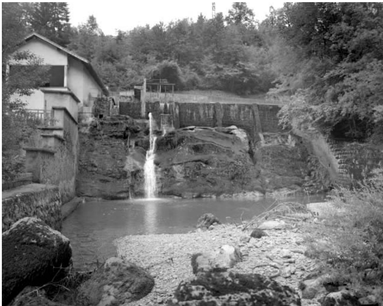
Barrage vu de l'aval.
