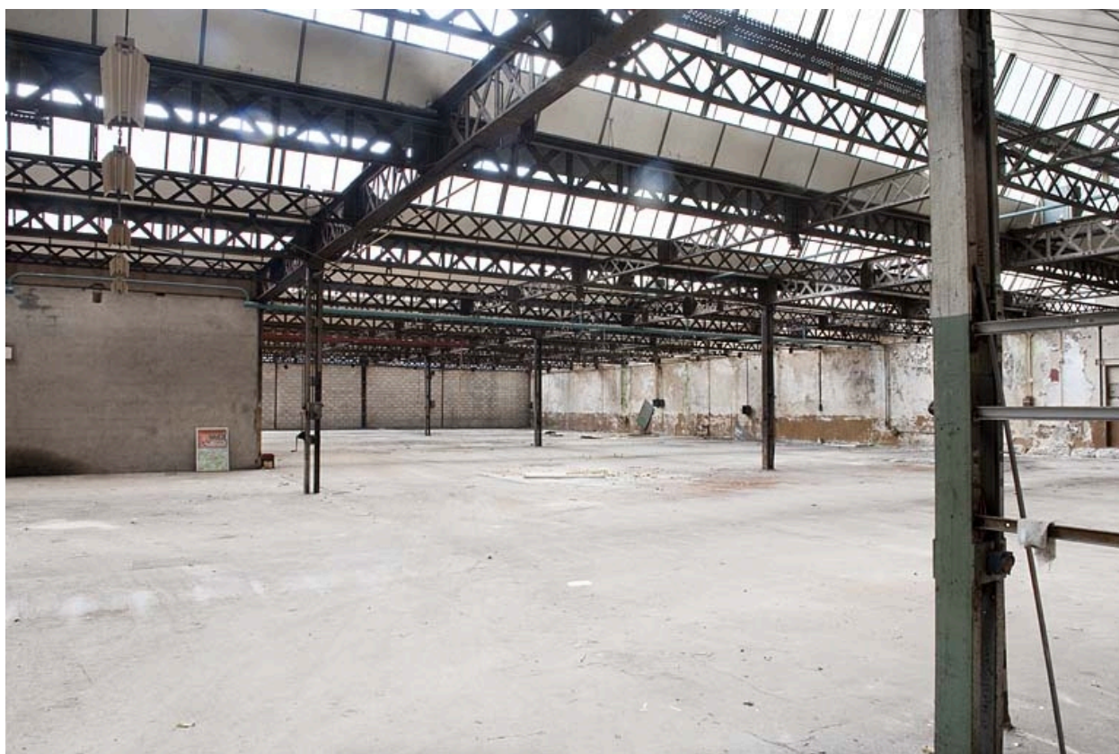
Atelier de fabrication. Vue depuis le sud-ouest.
